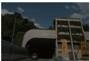
高速道路・藤巻出入口
