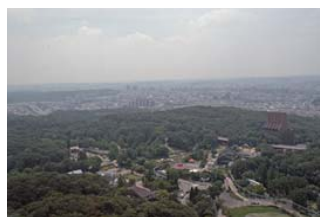
東山公園～藤巻の森（高速道路全景）
