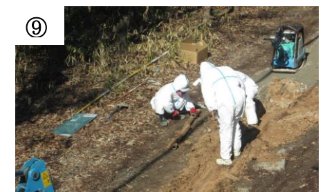
⑨ ⑩は昭和13年のアスベスト管の露出と除去作業
