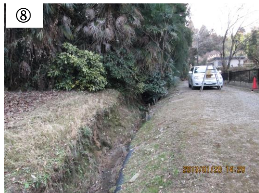
⑧ 流水でえぐられた道路
