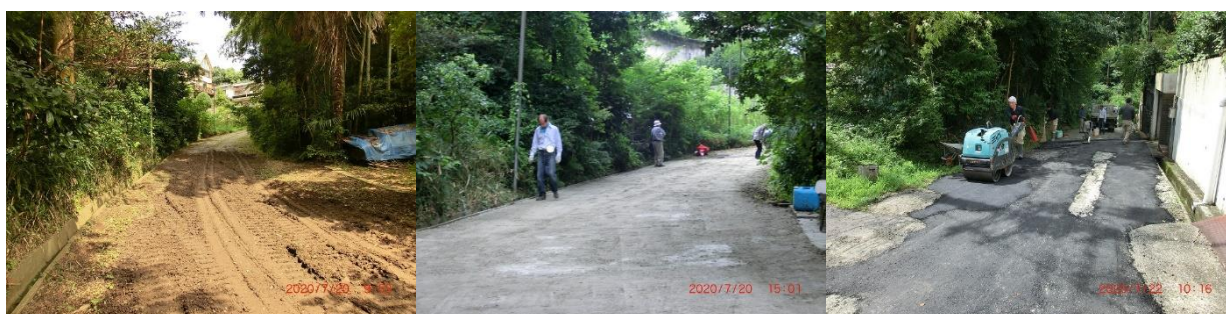
7月20日(月)~22日(火) 道路⑤、⑥整備工事
