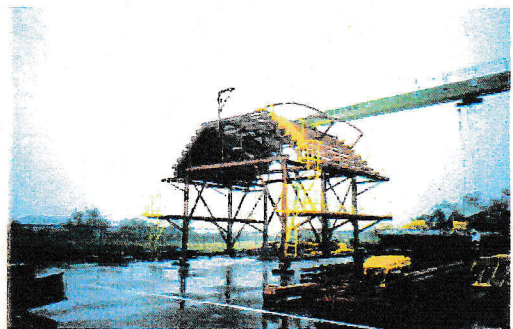
シート張台車、鉄筋台車
