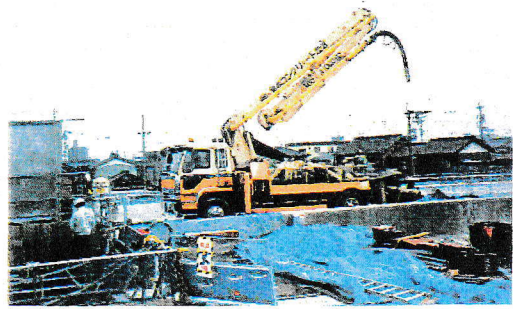
コンクリートポンプ車
