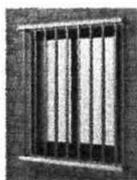
高強度の材質の物や、窓枠一体型の物もある。既存の格子は、ドライバーで外せないように、ネジ山をハンマー等で潰しておくとう�효的。
