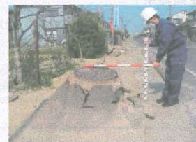
千葉県内で発生した液状化によるマンホールの浮き上がり
