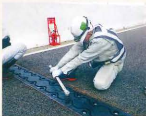
伸縮装置の取り替え
