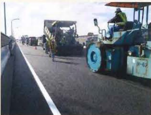
高機能舗装への打ち換え
